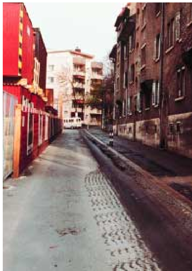
Wildbachstrasse: Situation vor der Bachoffenlegung
