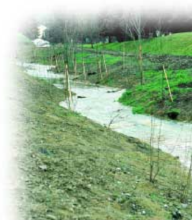
Sagentobelbach: kurz nach Fertigstellung
