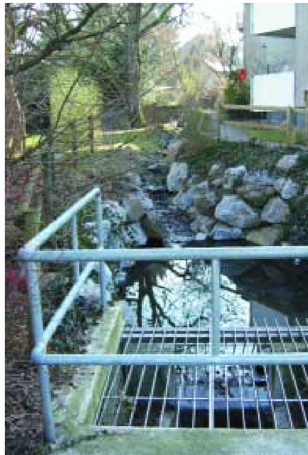
In diesem Bachabschnitt wird das vorbehandelte Badewasser vom Hallenbad Altstetten abgeleitet
