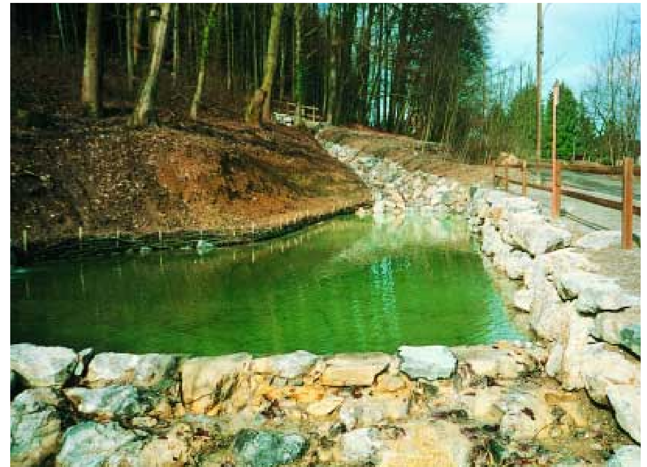
Hubenstrasse: der neue, naturnah gestaltete Geschiebesammler
