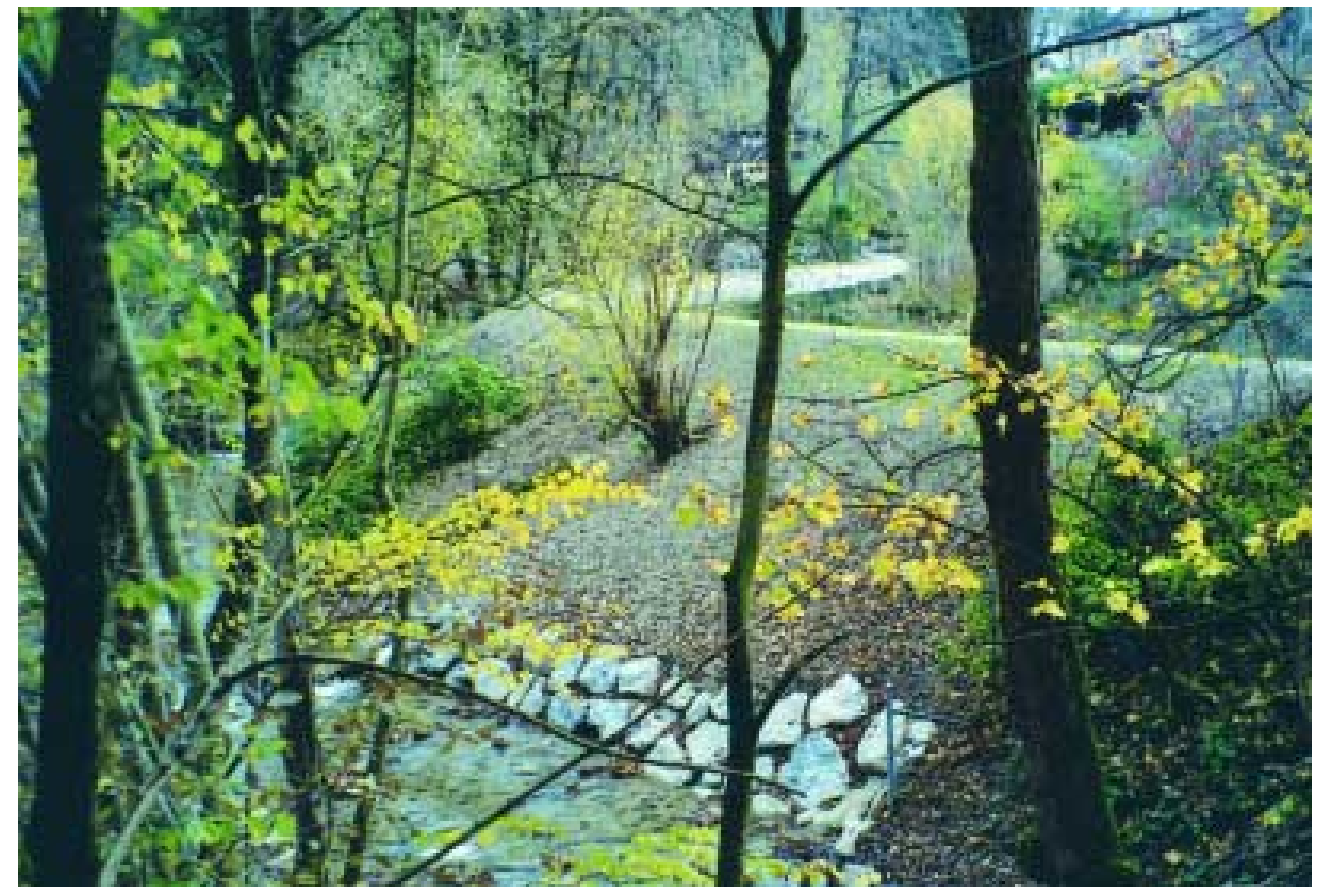
Der Damm des Mühleweihers Burgwies wurde naturnah saniert
