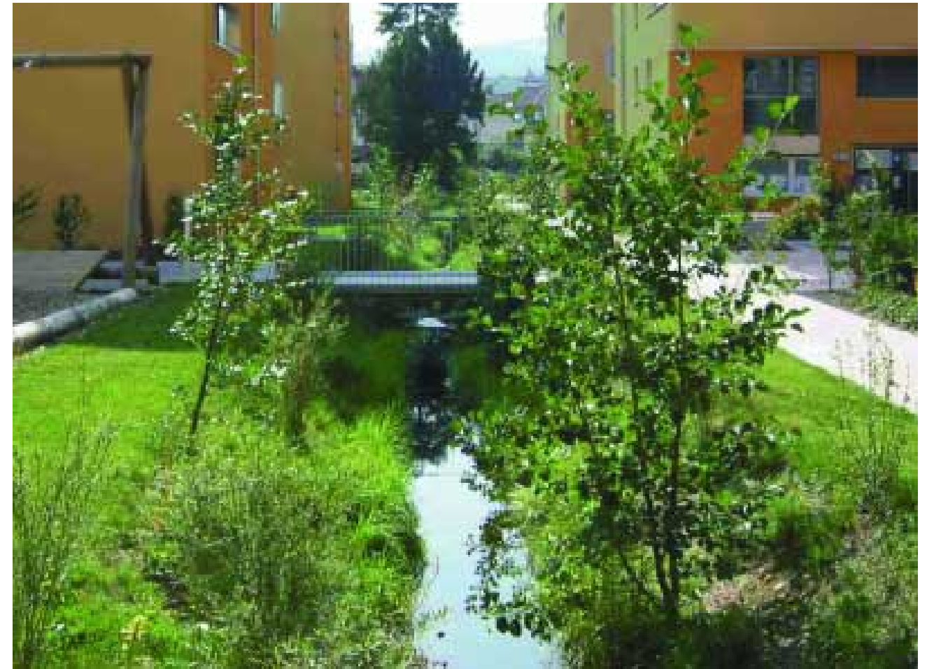
Ein Abschnitt des unteren Dorfbaches Altstetten wurde beim Neubau der Siedlung neu gestaltet (Auflage der Baubewilligung)
