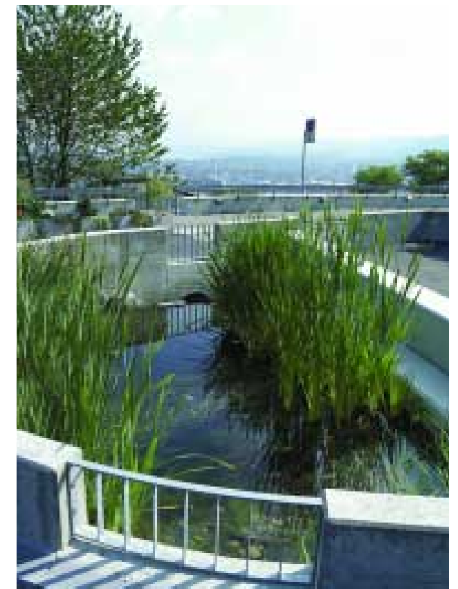
Neu offen gelegter Oerisbach im Einfahrtbereich zum Krankenhaus Käferberg
