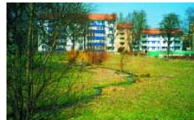
Rautistrasse: als Geländemulde gestaltetes Regenrückhaltebecken bei normaler Witterung
