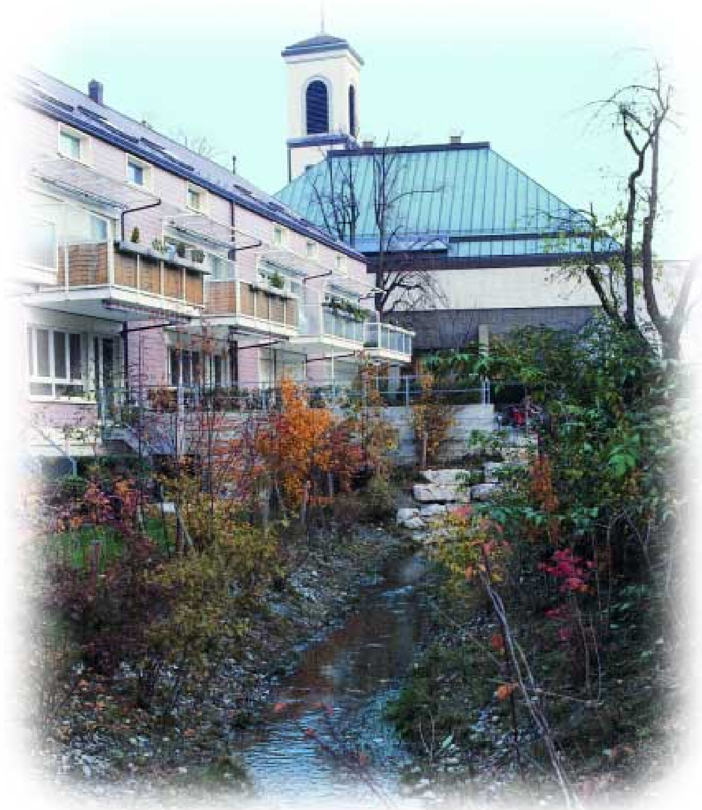
Der Albisrieder Dorfbach dient der Fremdwasserableitung sowie teilweise der Ableitung von nicht verschmutztem Regenwasser. Zudem erhöht er die Wohnlichkeit und bringt mehr Natur ins Quartier
