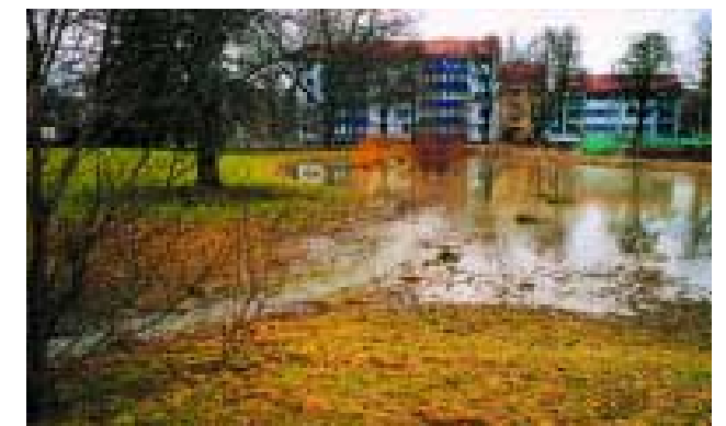
Rautistrasse: Das Rückhaltebecken ist nach einem starken Regen gefüllt
