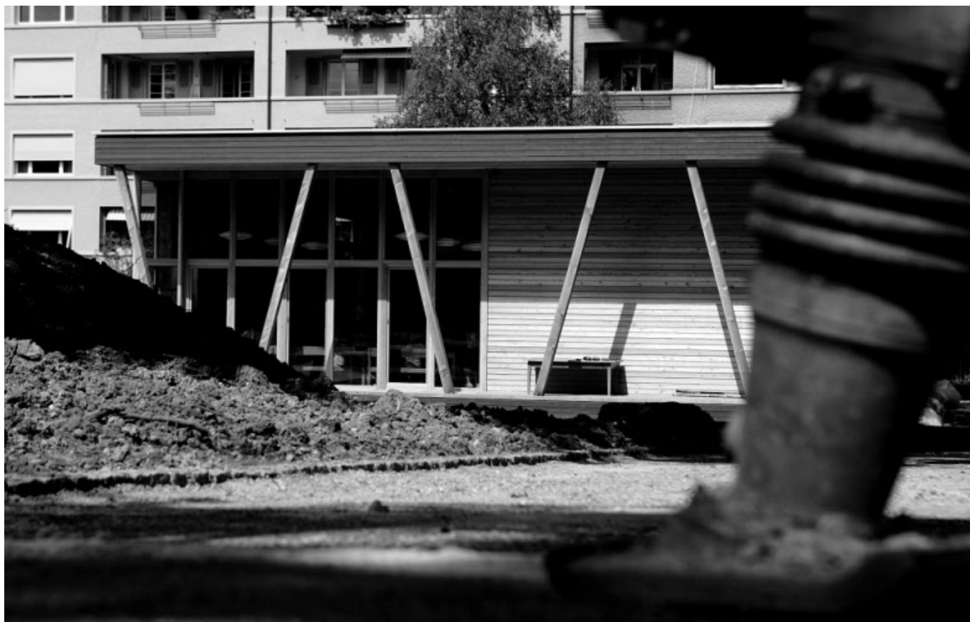
Der neue Kindergarten im Spitalacker ist fertig gebaut, am Umschwung wird noch gearbeitet.
